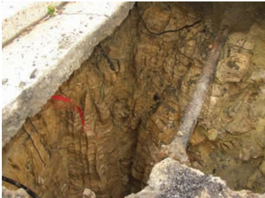
**Figure n°16:** Exemple d'effondrement de chaussée suite à des fuites du réseau d'assainissement – Commune de Villetaneuse, butte de Montmorency (photographie source CETE IF)
